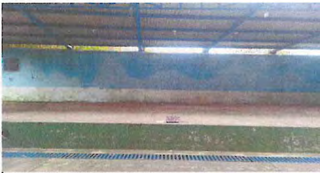
Pared deteriorada por la humedad
